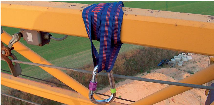
**Abbildung 9:** Mehrmaliges Umschlingen des Auslegerträgers bei der Erstellung einer Zwischensicherung an einem Kranausleger (Quelle: Werft)
