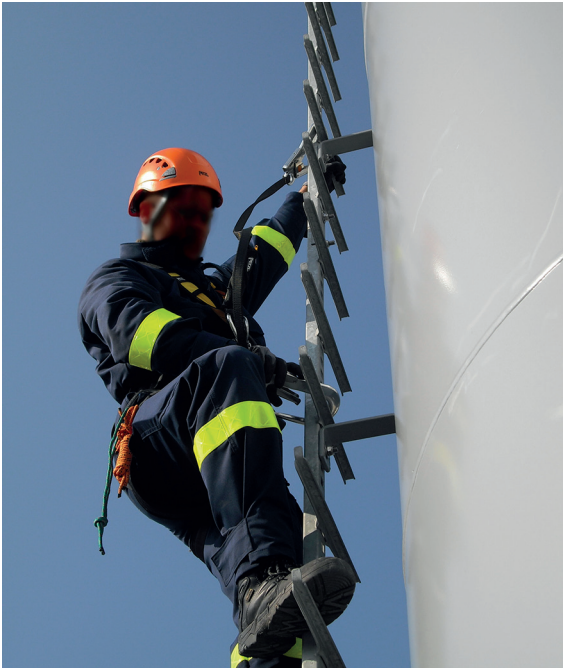
Abbildung 14: Sicherung auf Steigleiter mit Nahbereichssicherung. Wechselseitiges Einhängen der Karabinerhaken an der Laufschiene der Steigleiter (Quelle: Werft)
