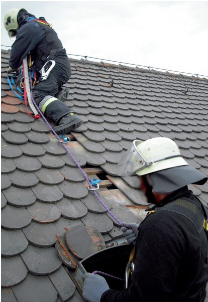
Abbildung 93: Senkrechter Vorstieg auf einem Satteldach (Quelle: Wertf)
