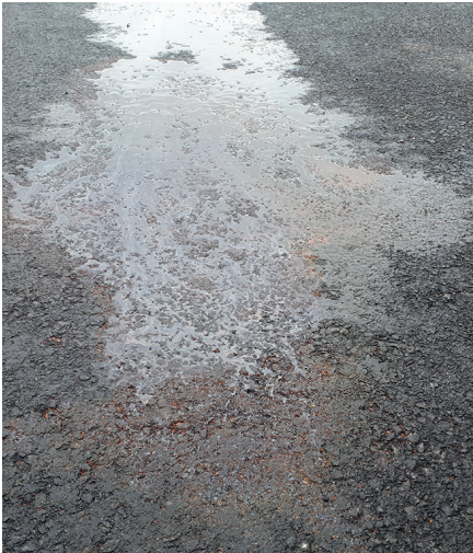
Abbildung 34: Regennasse Fahrbahn an der Stelle einer älteren Ölspur – die Straßenverunreinigung ist klar erkennbar. (Quelle: Dominique Christ)
