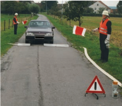
Abb. 42: Vorbildliche Sicherung von Schlauchbrücken (Quelle: Hans Kemper, Geseke)
