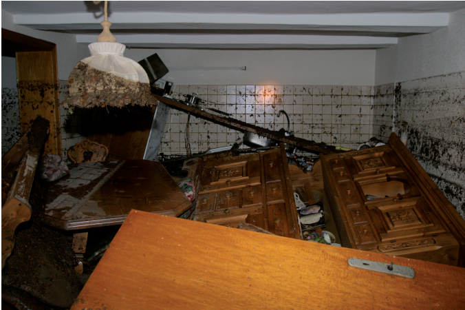
Von Sturzflut betroffene Kellerräume (Foto: Ralf Rohmoser von Glasow)
