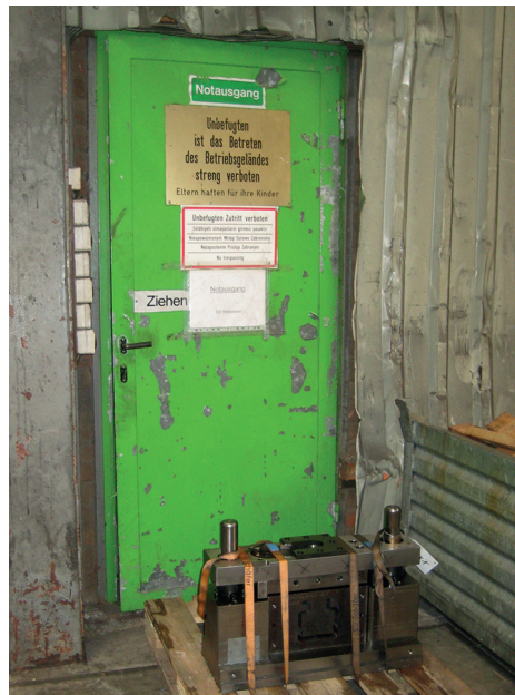
Abb. 18: Verschlossener Notausgang (links) und dazu noch verbotener Schlüsselkasten (OVG.NW Urteil vom a 1766/90; BVerwG Beschluss vom B5592 OVG Münster) (rechts) für den auch noch das Hilfsmittel zum Einschlagen der Scheibe fehlt.
