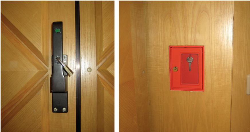
Abb. 18: Verschlossener Notausgang (links) und dazu noch verbotener Schlüsselkasten (OVG.NW Urteil vom a 1766/90; BVerwG Beschluss vom B5592 OVG Münster) (rechts) für den auch noch das Hilfsmittel zum Einschlagen der Scheibe fehlt.
