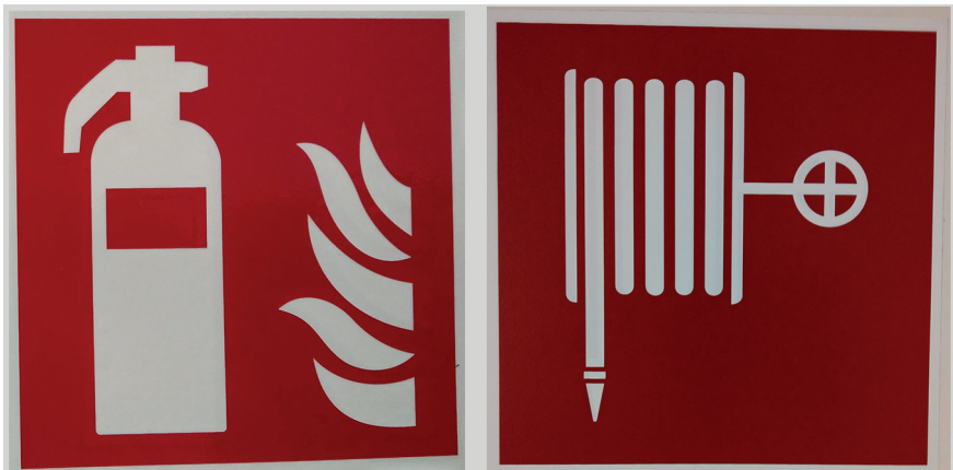
Abb. 21: Sicherheitskennzeichnung langnachleuchtend gekennzeichnet nach DIN 67510 (links) und ungeeignet (rechts), weil nicht langnachleuchtend (rot auf weiße Folie gedruckt) und somit bei Ausfall der Allgemeinbeleuchtung nicht mehr erkennbar.
