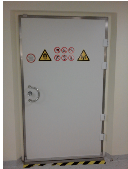
Abb. 5.2/1: Zugangstür zur MRT mit ASR-Kennzeichnung (Foto: Wein, Niederwörresbach)
