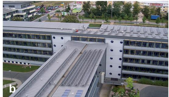
Abb. 41a und b: Beispiele für Gefahren durch Elektrizität im Rahmen von Drehleitereinsätzen. Stromeinspeisung über Dachständer auf einer Dachfläche und Photovoltaikanlage auf Flachdach.
