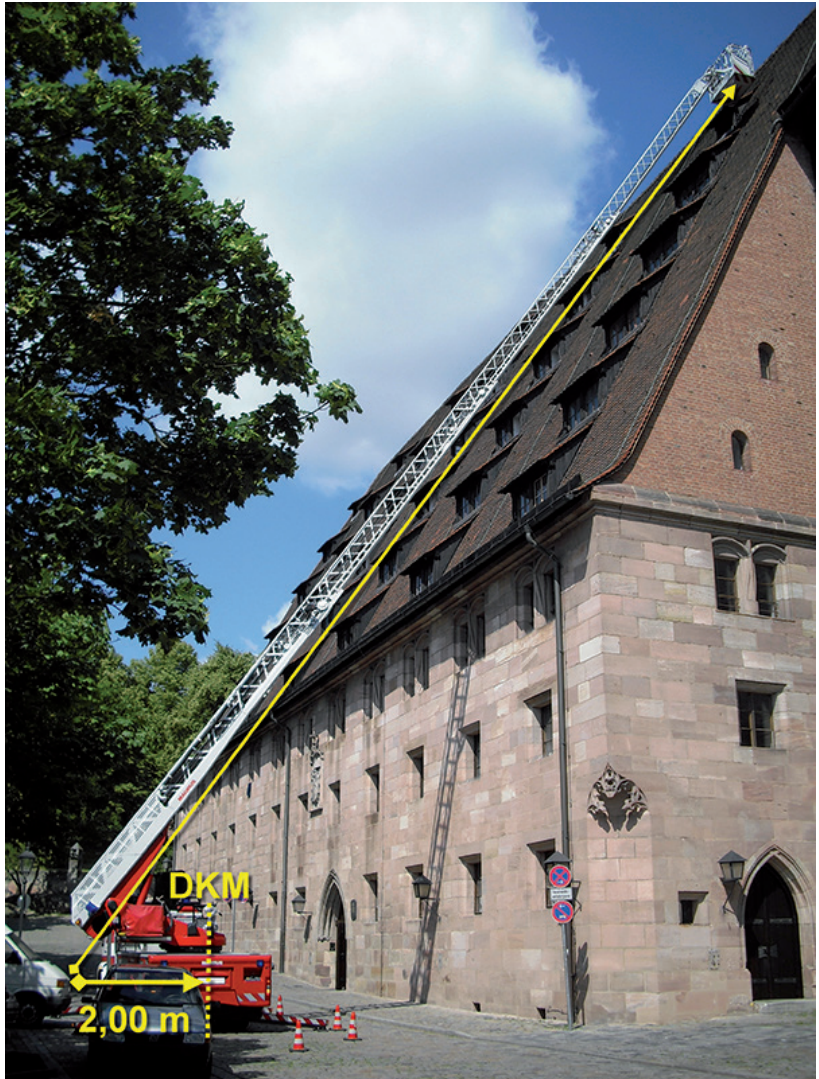
Abb. 142: Lage der Drehkranzmitte ca. 2,00 m vor dem Standplatz des Einweisers. Durch die hohe Lagerung des Leitersatzes auf der Lafette in etwa auf Kopfhöhe wird das Anleiterziel erreicht und Ausladung gespart. In diesem Fall erfolgt das Abfahren der Dachgauben mit dem Rettungskorb parallel zur Dachfläche.
