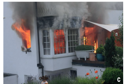
Abb. 15: Veränderung der Rauchfarbe von hell (a: fast weiß) nach dunkel (b und c) aufgrund von zerstörten Fensterscheiben (Fotos: Rossbach, Wuppertal)
