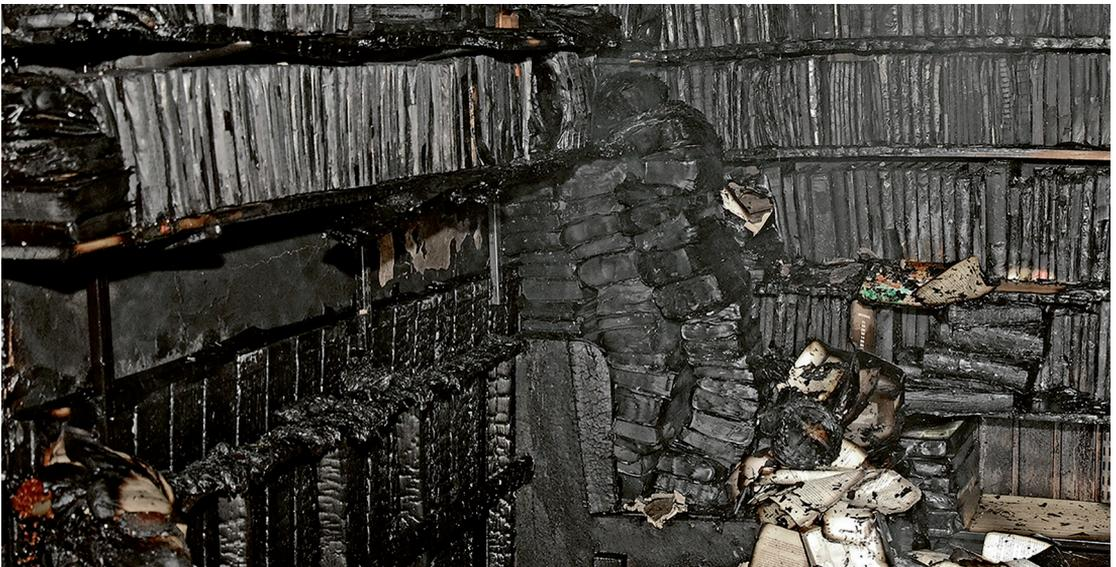
Abb. 50: Hier ist das Ablöschen/Abkühlen größerer Oberflächen erforderlich (Foto: Konjer, Nordhorn)
