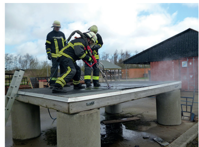
Abb. 60: Durchtrennen von Sattel- und Flachdach (Fotos: Fuchs)
