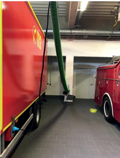
Abb. 51: Unkorrekt aufgesetzte Quellenabsaugung (Quelle: Marcus Bätge)
