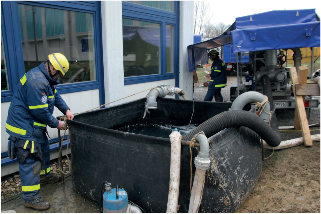
Abb. 19: Pumparbeiten (Foto: THW OV Siegburg)
