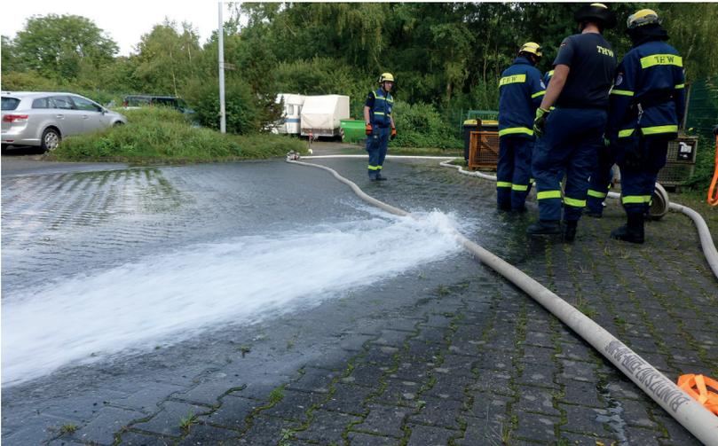
Abb. 40: Improvisierte Wassersperre aus B-Schlauch
