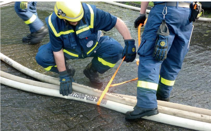
Abb. 41: Binden von Schlauchbündel für improvisierte Wassersperre
