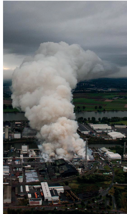
Abb. 47: Perspektive des Luftbeobachters aus dem Hubschrauber bei einem Brand. Man erkennt die Ausbreitung der Rauchwolke und auch den Verlauf in den oberen Schichten. Quelle: Mit freundlicher Genehmigung Polizeifliegerstaffel NRW
